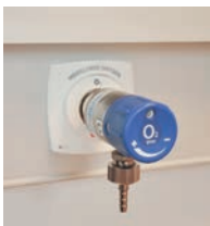
Dozownik tlenowy połączony z medycznym punktem poboru
